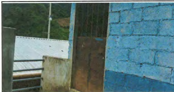
Foto 1: Sustrucción de puertas en área de cocina
