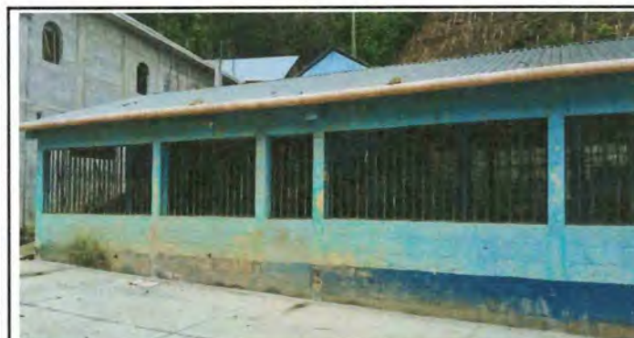
Foto 3: Mantenimiento y mejoramiento de balcones lado frente del centro educativo. Mantenimiento de pintura en paredes interiores y exteriores de todos los ambientes.
