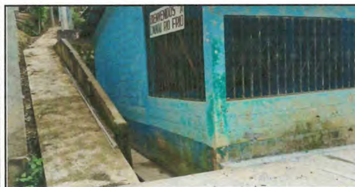
Foto 5: Reparación de muro perimetral, colocación de malla y tubos galvanizados.
