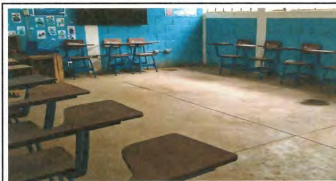
Foto 4: Mejoramiento de pisos de concreto a piso cerámico en todas las áreas del centro educativo, aulas, bodega, dirección y corredor.
